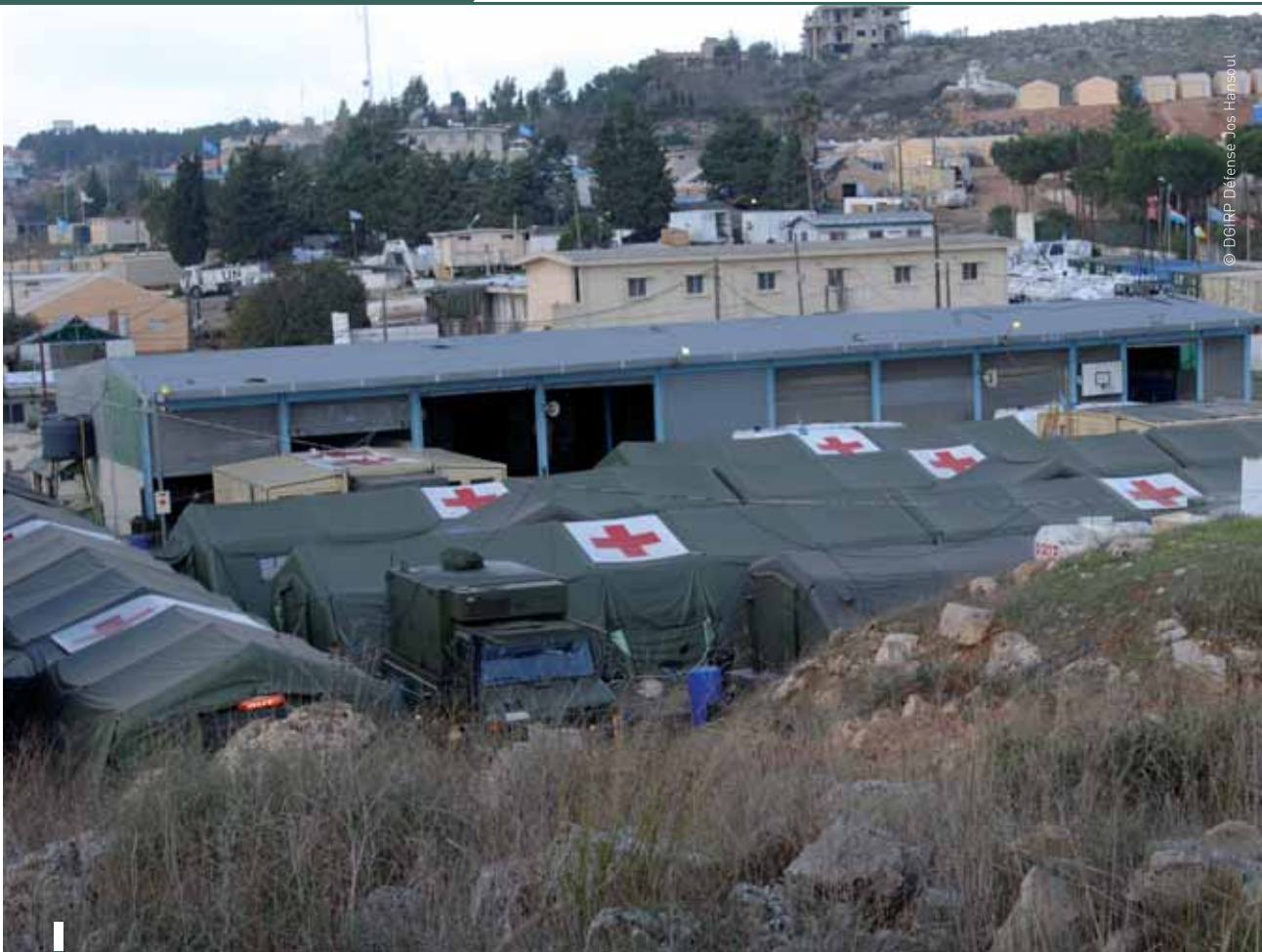
Het veldhospitaal werd in nauwelijks drie dagen tijd gebouwd. Het bestaat uit tenten en containers met een oppervlakte van meer dan 2.000 m 2 , en beschikt over alle moderne technologie inzake intensieve zorg, radiologie, laboratoriumuitrusting, chirurgie en tandheelkunde.
